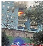
VIA DEI LAURI. Le fiamme si sono spri-giate dal terzo piano. (Foto CDT)
